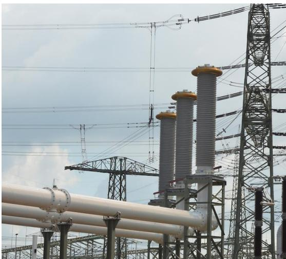
*Darstellung der gasisolierten Schaltanlage
