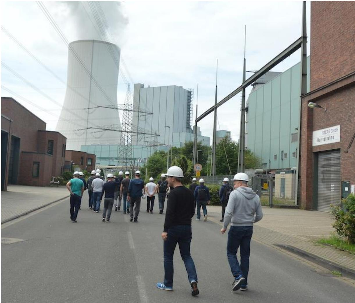
Anschließend erfolgte die Besichtigung des Kraftwerks Walsum. Es handelt sich hierbei um ein Steinkohlekraftwerk, welches neben der reinen elektrischen Energie die naheliegende Umgebung mit Fernwärme versorgt. Hierdurch wird ein höherer Wirkungsgrad im Gesamten erzielt, der sich jedoch durch kleinere Abstriche in der Erzeugung der elektrischen Leistung bemerkbar macht.
