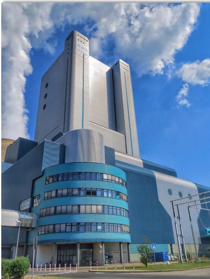
Der besichtigte Block K mit der RWE Bezeichnung BoA (Braunkohlekraftwerk mit optimierter Anlagentechnik) wurde 2003 in Betrieb genommen und hat eine elektrische Nettoleistung von ca. 944 MW und einen elektrischen Wirkungsgrad von ca. 43% (spez. Kohleverbrauch 0,9 kg/kWh). Das Kesselhaus ist mit 172 m das
