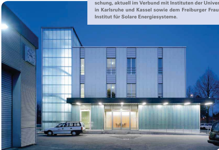
Abb. 1: Die Sanierung des Verwaltungs- und Sozialgebäudes der kommunalen Entsorgungsbetriebe in Remscheid zum Niedrigenergiehaus mit passiver Kühlung über Nachtlüftung und Einsatz von Latentspeichermaterial zur Reduktion der sommerlichen Raumtemperaturspitzen. Architektur: ACMS, Wuppertal. Foto: T. Riehle
