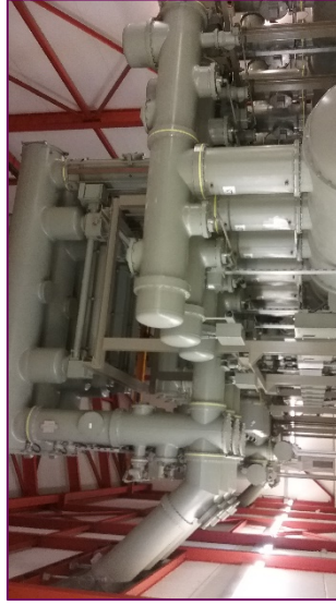
Gasisolierte Hochspannungsschaltanlagen
